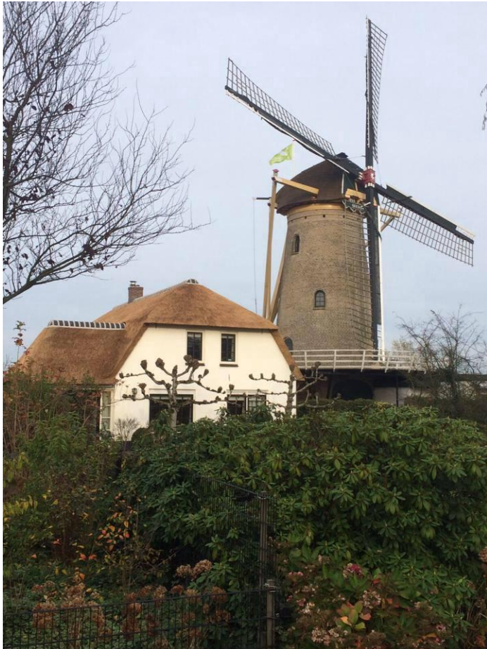
Het huis van de familie Verhoef naast de molen met het mooie - eerder dit jaar vernieuwde - rieten dak, al in de 19 e eeuw was dit de molenaarswoning,
